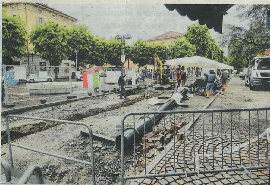
L'intervento effettuato da Lario Reti Holding sulla principale condotta idrica della città
