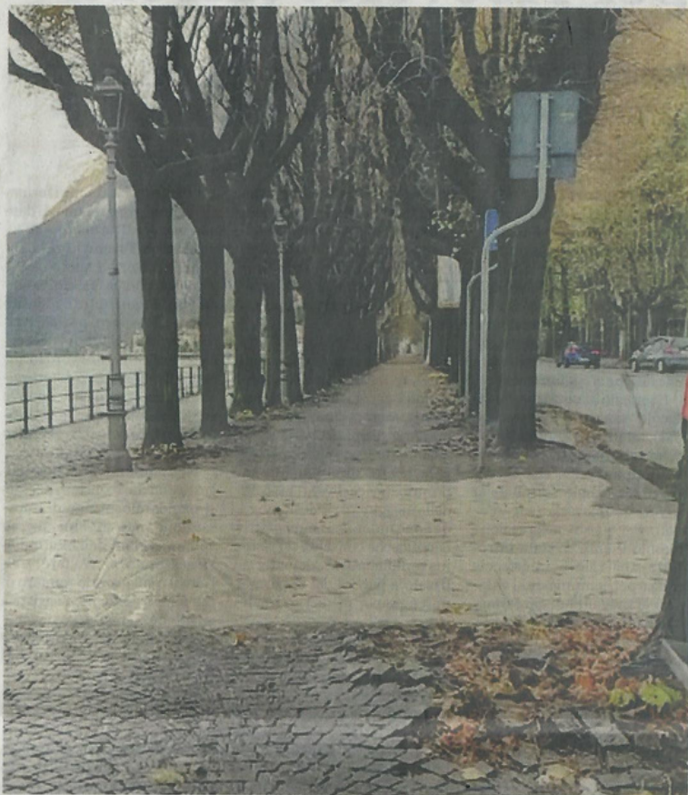
Lo strato di cemento posato sopra la zona dello scavo dell'estate 2023
