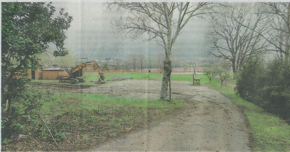
Così appare l'area interessata dal cantiere del quarto ponte a Pescate
