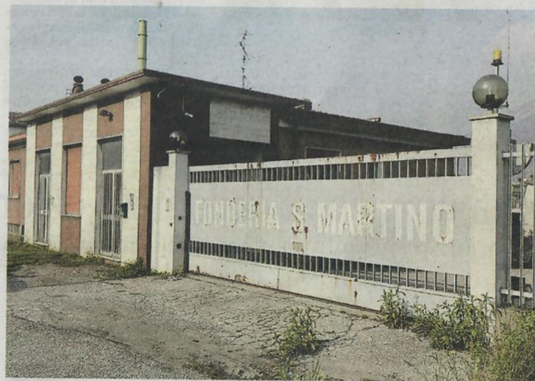
L'ingresso dell'ex Fonderia San Martino di via Spluga dove voci sempre più insistenti parlano del possibile arrivo della grande distribuzione commerciale
