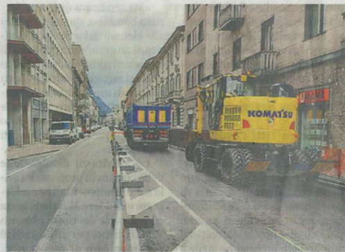
Gli scavi, ora terminati, in corso Martiri
