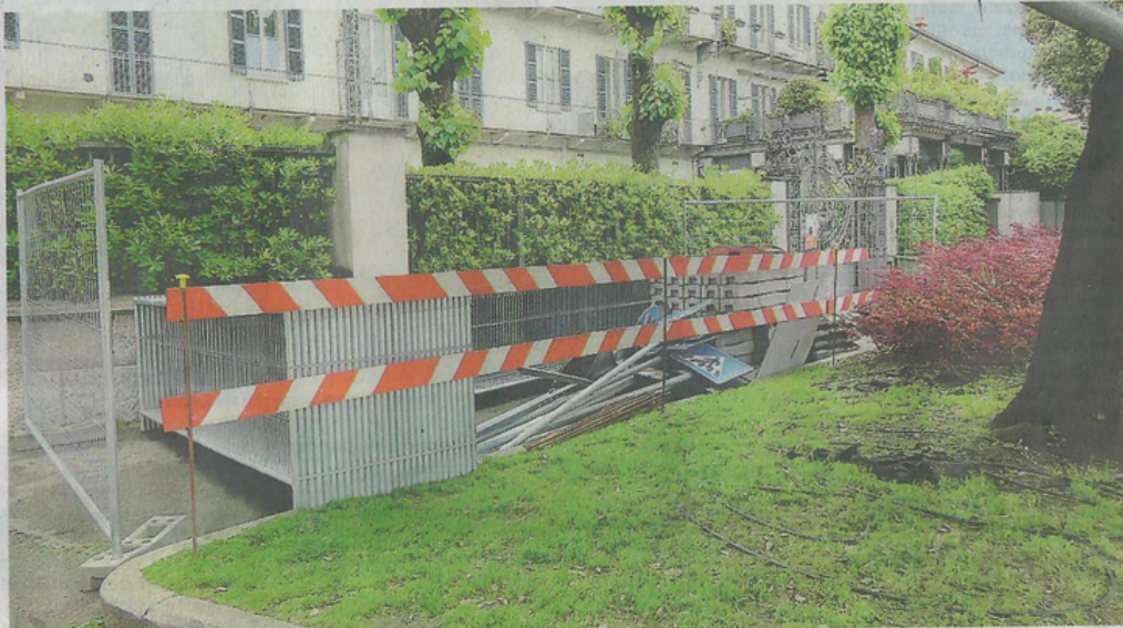
Si comincia a depositare il materiale necessario per la recinzione di cantiere
