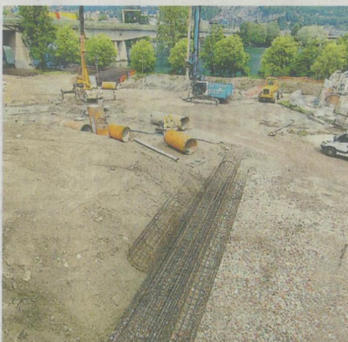
Il cantiere del Quarto ponte a Pescate
