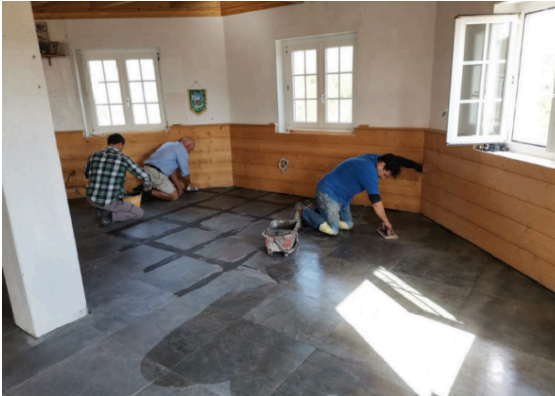
Lavori al Rifugio Cazzaniga Merlini
