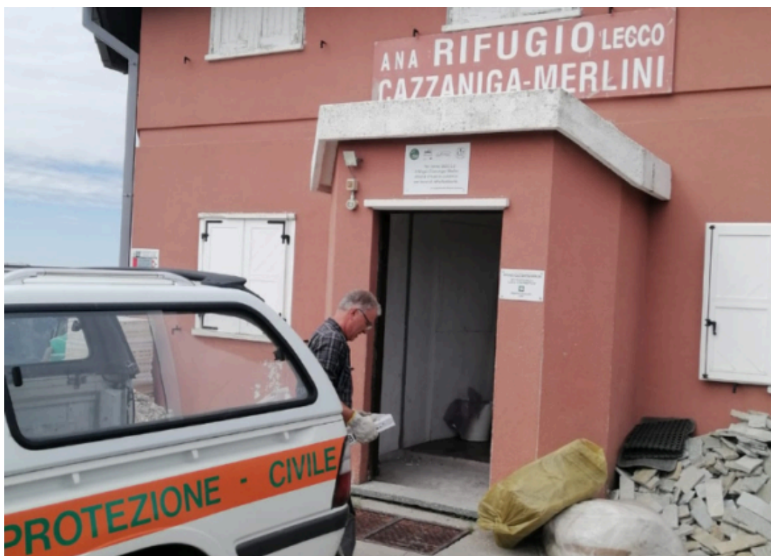
Lavori al Rifugio Cazzaniga Merlini
