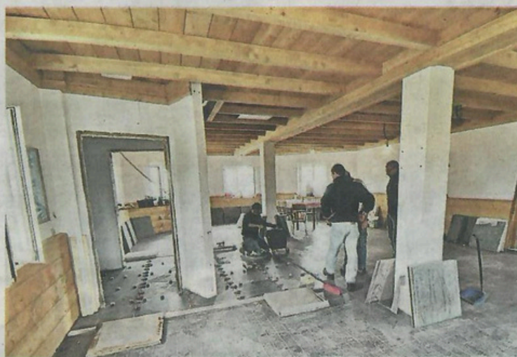
Lavori in corso nel rifugio costruito tra il 1927 e il 1930 e poi daccapo nel 1944 dopo essere stato abbattuto durante la Seconda guerra mondiale
