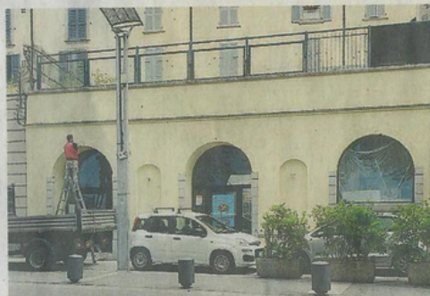
I lavori per sostituire l'insegna e adattare i locali
