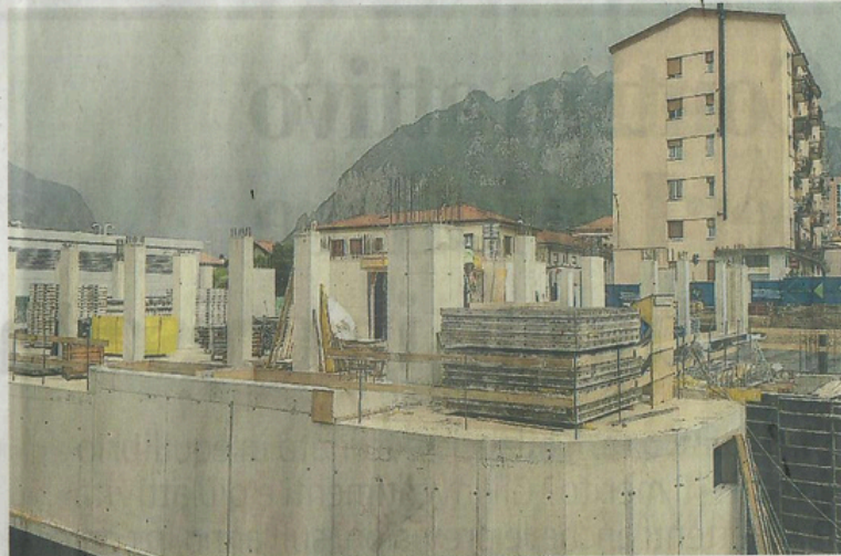
Sono partiti i lavori per la realizzazione del terzo lotto di "Ca' del Lario", nell'area ex Pagani
