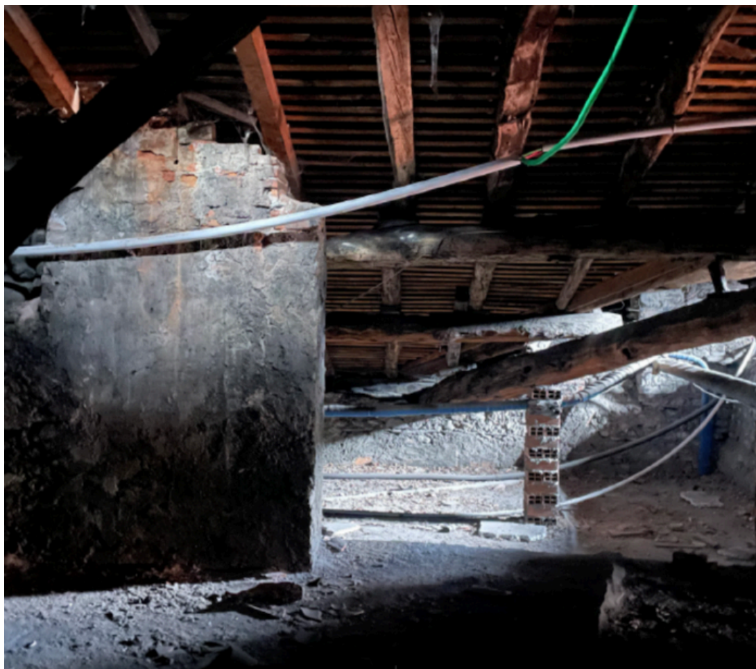
Il sottotetto del corpo nobile
