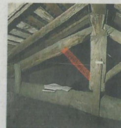
Rinforzo di elementi in legno
