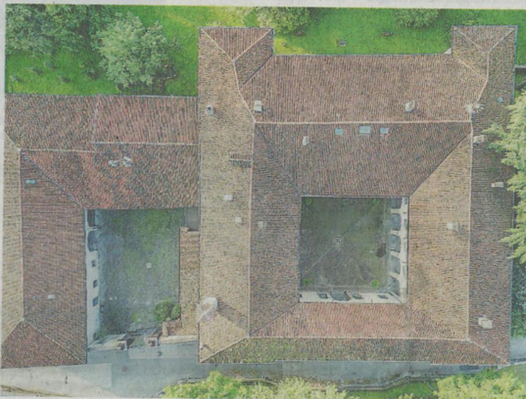
Verrà scopperchiato il tetto del corpo nobile di villa Manzoni
