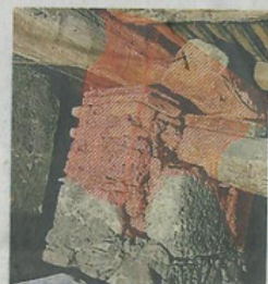
Ripristino di vincoli e muratura
