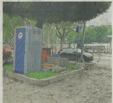
Un altro scorcio del cantiere
