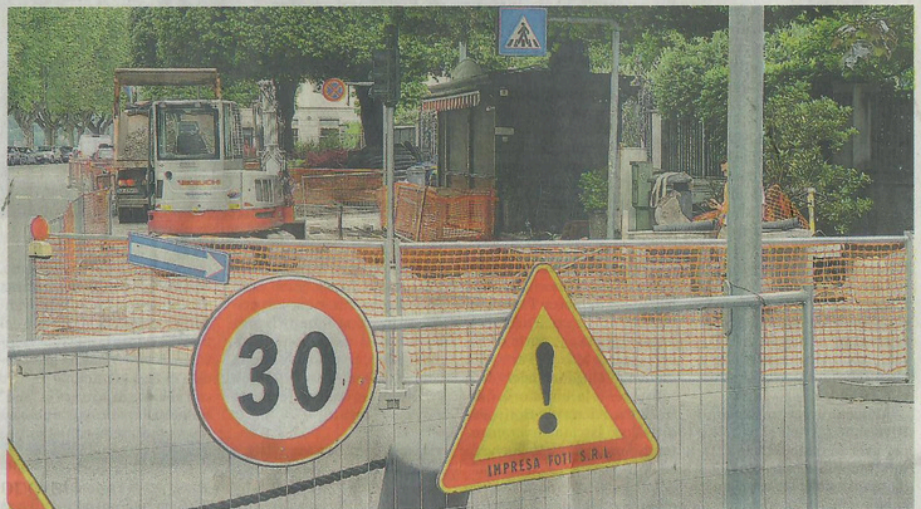
Il cantiere allo stato attuale
