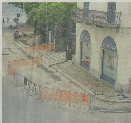
I marciapiedi sono stati sbancati
